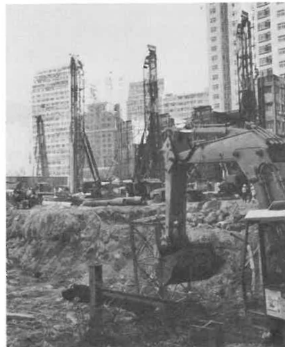
建築業之噪音
